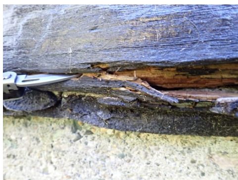
Mindre råteskade.
