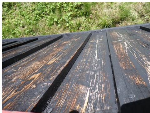
Slitt rekkverk.
