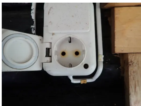
Skadet stikkontakt.
