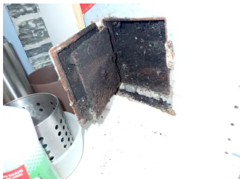
Sotluke plassert inntil kjøkkeninnredning.
