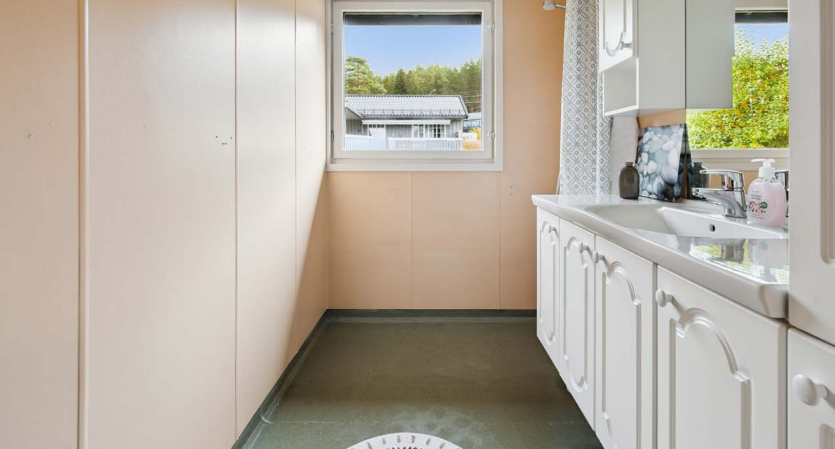
Badet med vinylbelegg på gulv og malte våtromsplater på vegger.
