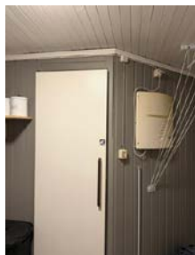
Ikke luftespalte mot tilstøtende rom
