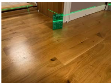
Soverom i underetasjen
