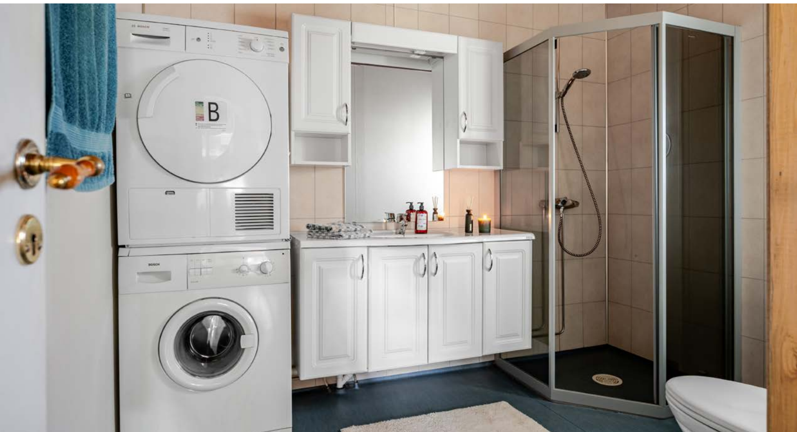
Baderommet har våtromsbelegg på gulv, varmekabler og våtromsplater kombinert med vinyltapet på veggene. Oppgradert i 2004 med våtromsplater og sanitærutstyr.
