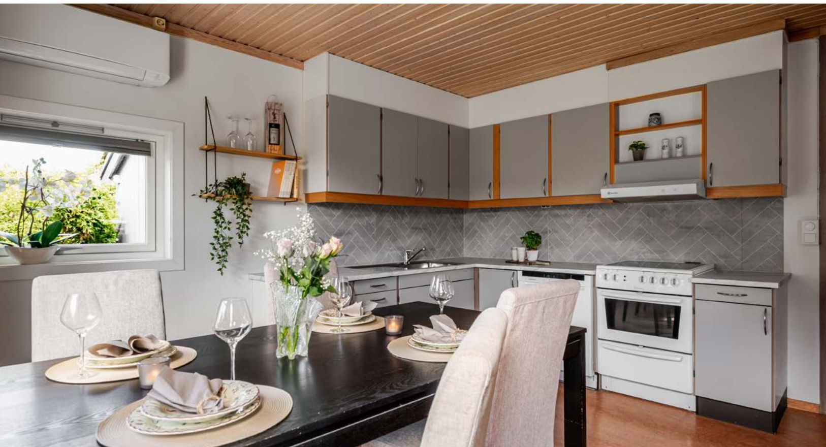
Kjøkkenet ble oppgradert i 2023. Frontene ble malt, det ble montert ny laminert benkeplate med nedfelt oppvaskkum, samt montert flotte plater i benkeryggen.
