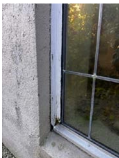
Råteskader i vinduer og glasslister.
