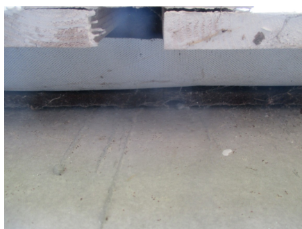
God lufting bak kledningen.
