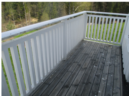
Deler av veranda ut i fra loftet.
