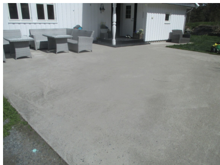
Større støpt terrasse
