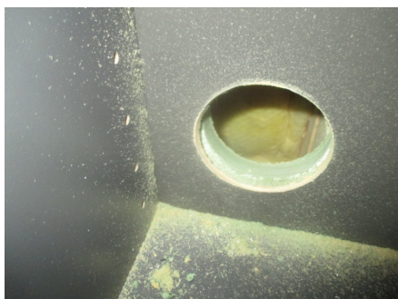
Hulltaking i vegg mot bad
