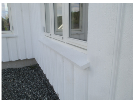
Deler av kledningen med tilhørende belistninger
