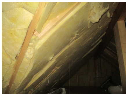
Plassbygget sperrekonstruksjon.
