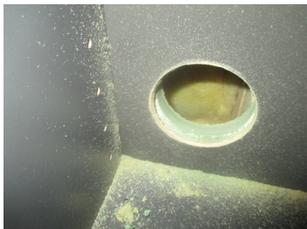
Hulltaking fra benkeskap på vaskerommet
