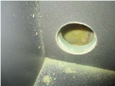
Hulltaking fra benkeskap på vaskerommet
