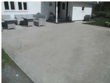
Større støpt terrasse
