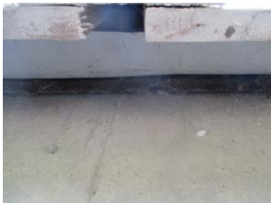
God lufting bak kledningen.
