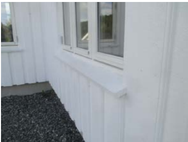
Deler av kledningen med tilhørende belistninger
