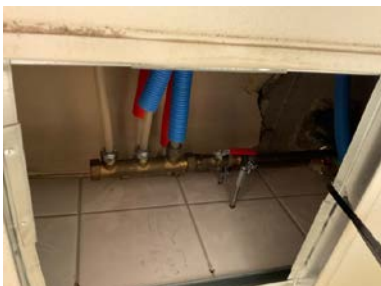
Rør-anlegg i tak i bad.
