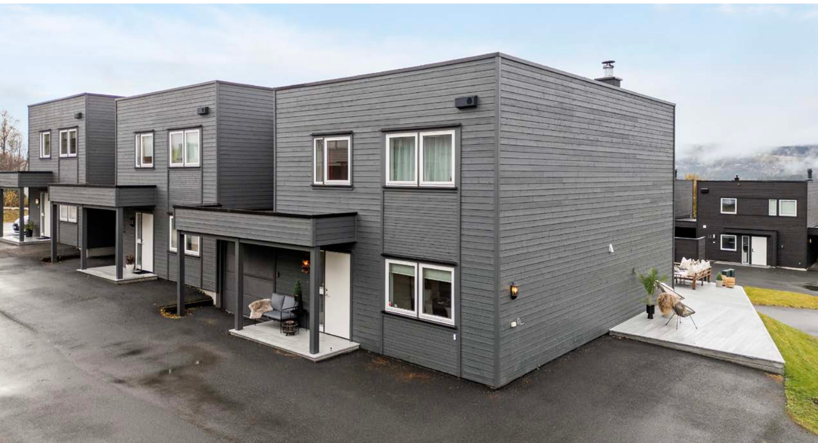
Asfaltert foran inngangspartiet.
