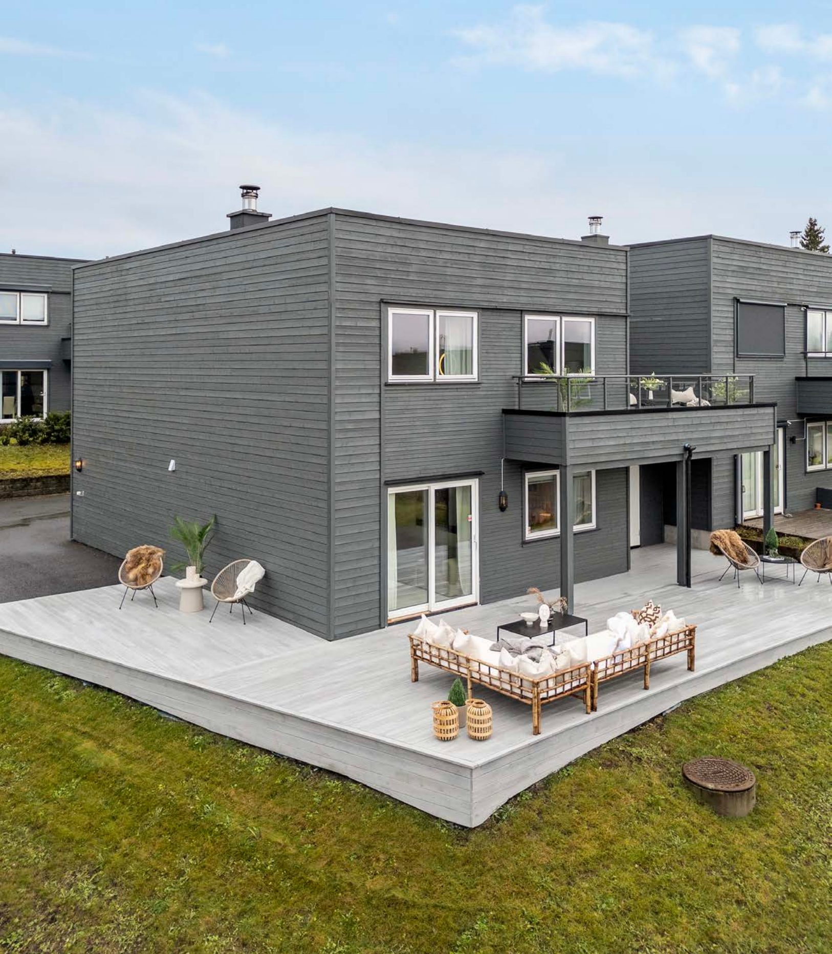
Stor terrasseplattung utenfor stue i 1. etasje.
