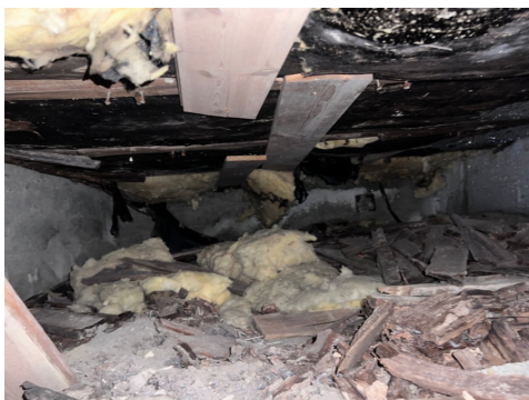
Skader i kryprom og gulvkonstruksjon
