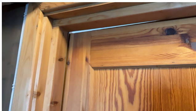
Utettheter mellom dørblad og karm
