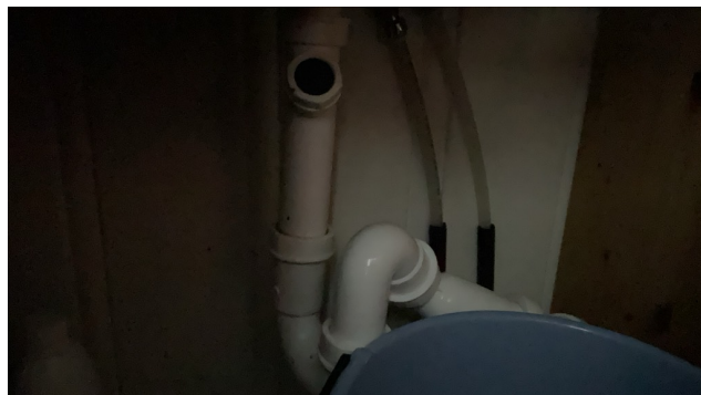
Etablert mot yttervegg
