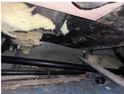
Skader i kryprom og gulvkonstruksjon
