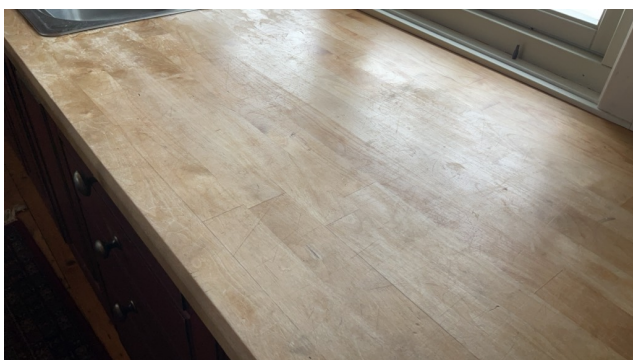
Slitasje på benkeplate, anbefales vedlikehold
