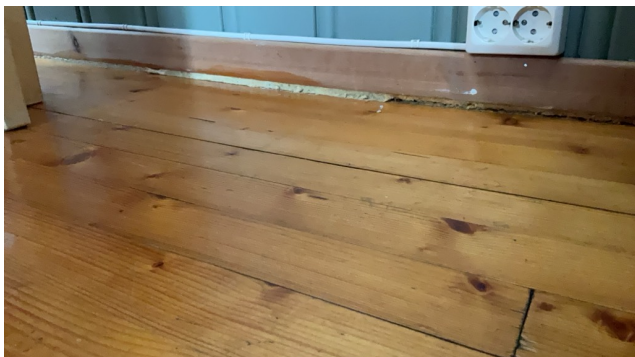
Glipper mellom gulv og gulvlist
