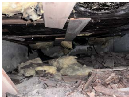
Skader i kryprom og gulvkonstruksjon
