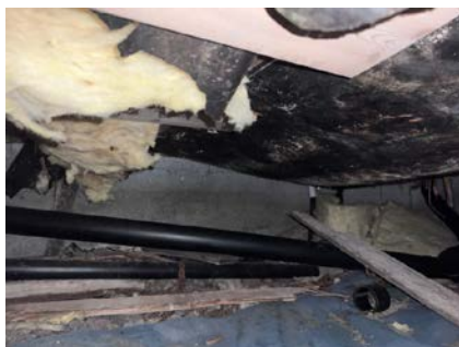
Skader i kryprom og gulvkonstruksjon
