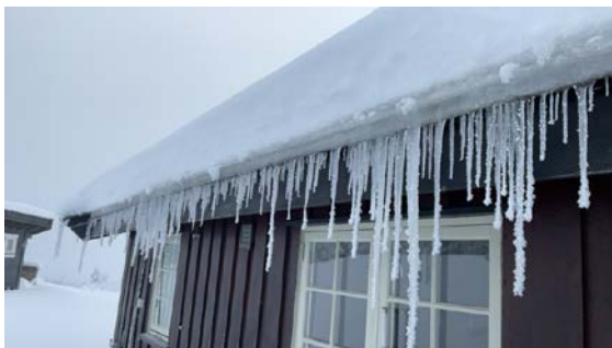
Is/kondens på begge sider av konstruksjonen
