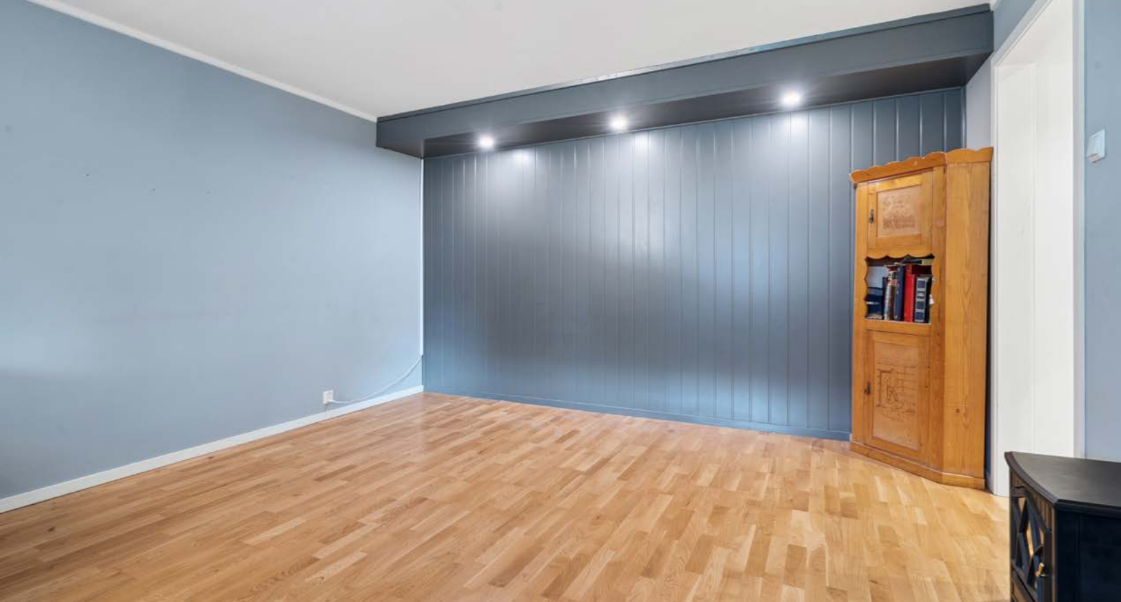
Det er vegger med malte mdf. veggplater og gulv med eikeparkett.
