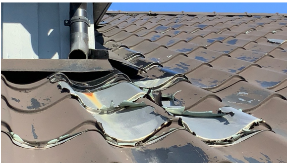
Synlig avfalssing av lakk på takplater.
