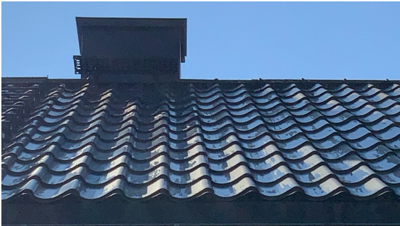
Synlig avfalssing av lakk på takplater.
