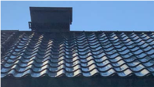
Synlig avfalsning av lakk på takplater.
