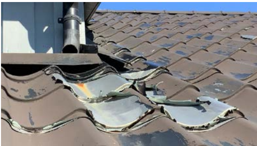
Synlig avfalsning av lakk på takplater.
