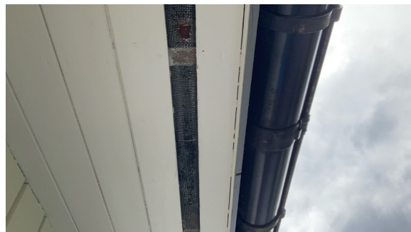
Lufting i gesimser.
