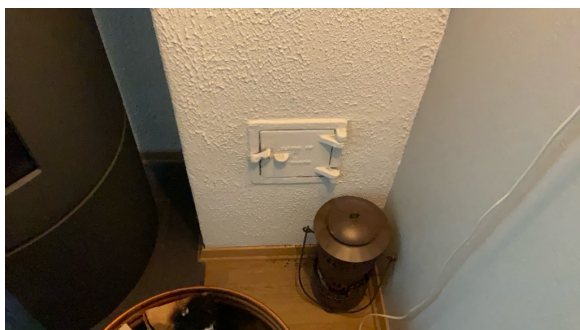
Sotluke for nærmere treverk.
