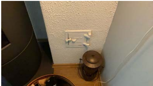
Sotluke for nærme treverk.
