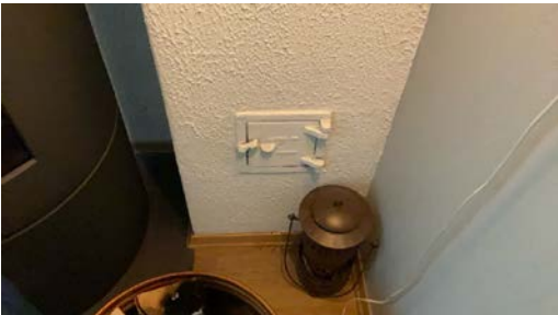
Sotluke for nærmeste treverk.
