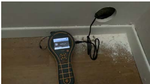
Fuktmåling i konstruksjon mot dusjsone.
