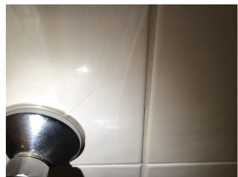
svelling/fuktskade
