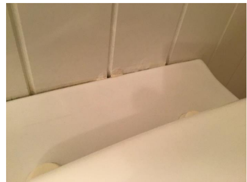
svelling/fuktskade
