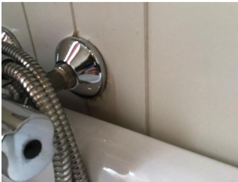
svelling/fuktskade
