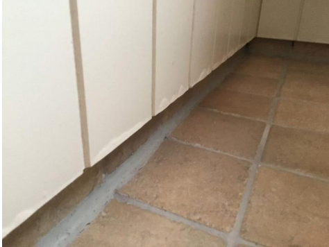
svelling/fuktskade
