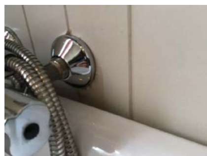
svelling/fuktskade
