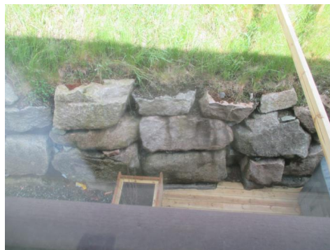
Deler av forstøtningsmur.
