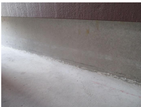
Støpt ringmur i rundt boder.
