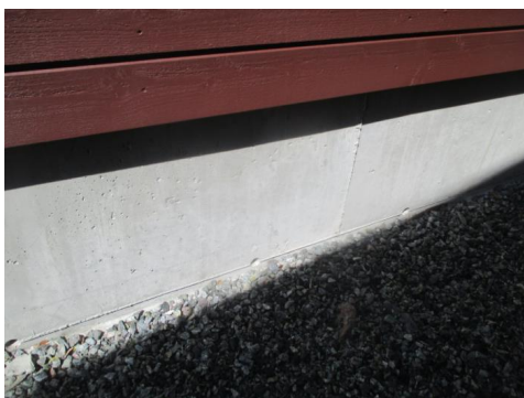
Isolerte ringmurselementer.
