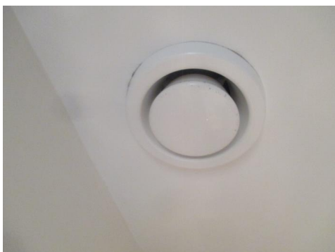
Avtrekk i fra badet.
