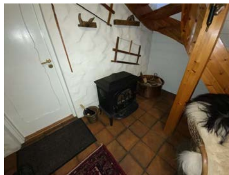
Besiktigelse av ildsted.
