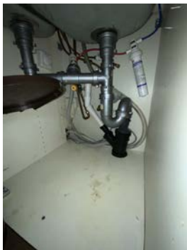
Besiktigelse av røropplegg i benkeskap på kjøkken.
