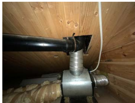
Kontroll rundt rørgjennomføringer i takkonstruksjonen.
