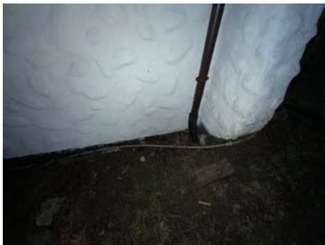
Kontroll av drenering/fuksikring.
