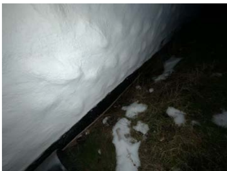
Kontroll av drenering/fuksikring.
