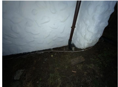
Kontroll av drenering/fuktsikring.
