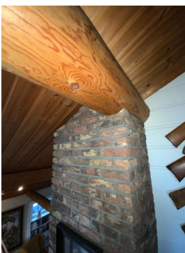
Ingen synlige lekkasjer rundt pipeløp.
