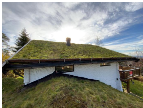
Besiktigelse av taktekke.
