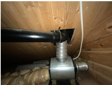
Kontroll rundt rørgjennomføringer i takkonstruksjonen.
