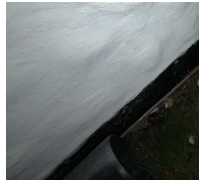
Kontroll av drenering/fuktsikring.
