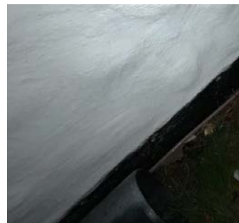
Kontroll av drenering/fuktsikring.
