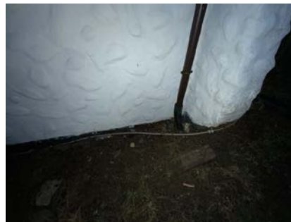
Kontroll av drenering/fuktsikring.
