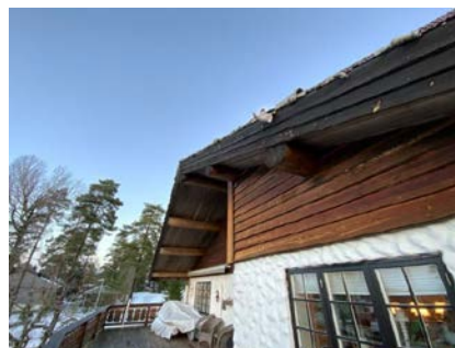
Ender på bærende takåser fremstår uten synlige råteskader på befaringsdagen. Endestokker er varmebehandlet.
