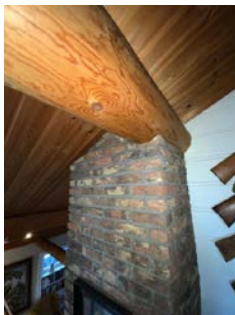
Ingen synlige lekkasjer rundt pipeløp.
