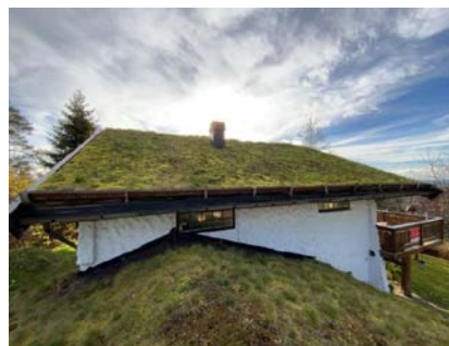
Besiktigelse av taktekke.
