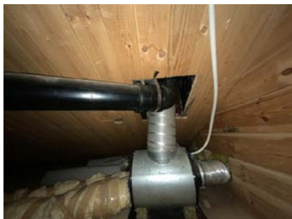
Kontroll rundt rørgjennomføringer i takkonstruksjonen.
