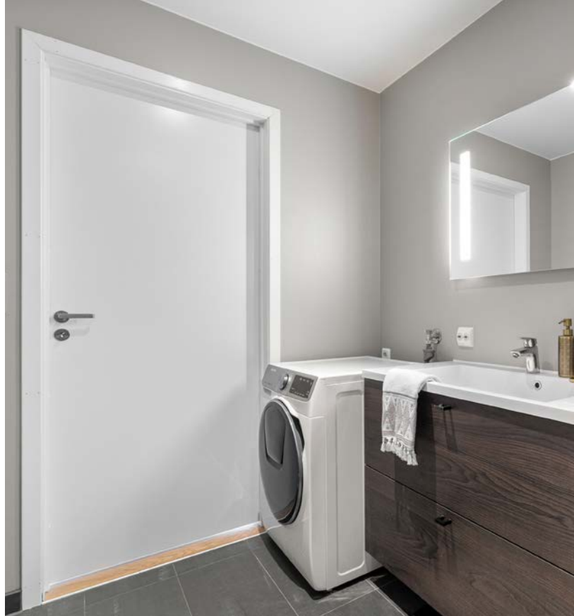
Flis på gulv, sokkel flis og malt strier på vegg. Flis på vegg i dusjsonen.
