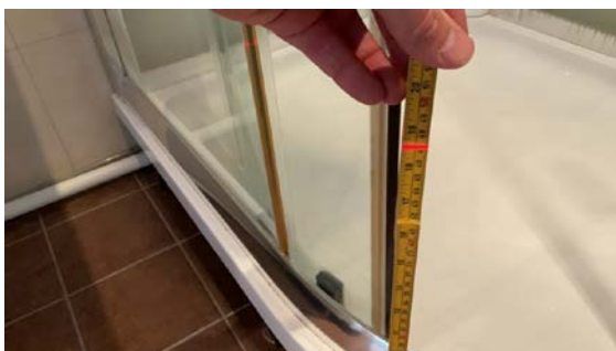
Målt høyde på 47 cm foran dusjkabinett, høydeforskjell på 1 cm
