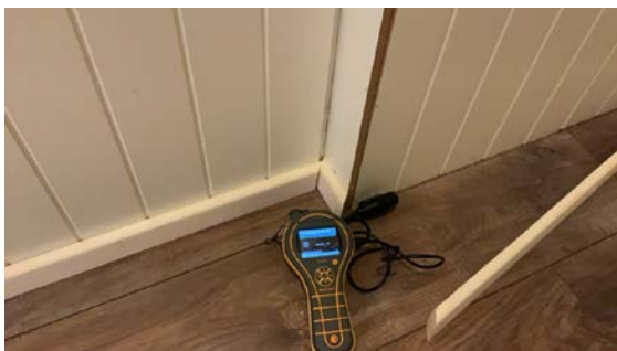
Ved fuktmåletaking av vegg ved innebygd sistene var det ikke fuktutslag
