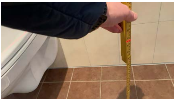
Høyde på 47 cm ellers på gulv og tilnærmet flatt
