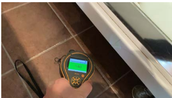
Ved fuktmåletaking av overflatesøk i dusj var det ikke fuktutslag
