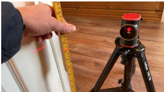
Høyde utifra laser ved terskel, høyde på 46 cm
