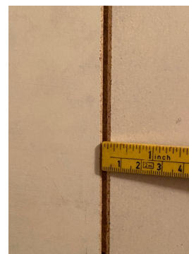
Skjøte på vinylbelegg i gangen, underetasjen.
