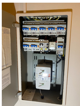
Manglende tetting av hull i elskap.
