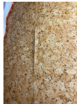
Skjøte på vinylbelegg i gangen, underetasjen.
