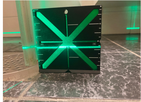
Måling av fall til sluk.
