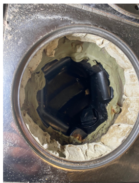
Ingen synlig mansjett/tetting mot rørgjennomføring.
