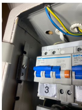
Manglende tetting av hull i elskap.
