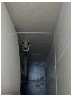
Ingen synlig mansjett/tetting mot rørgjennomføring.
