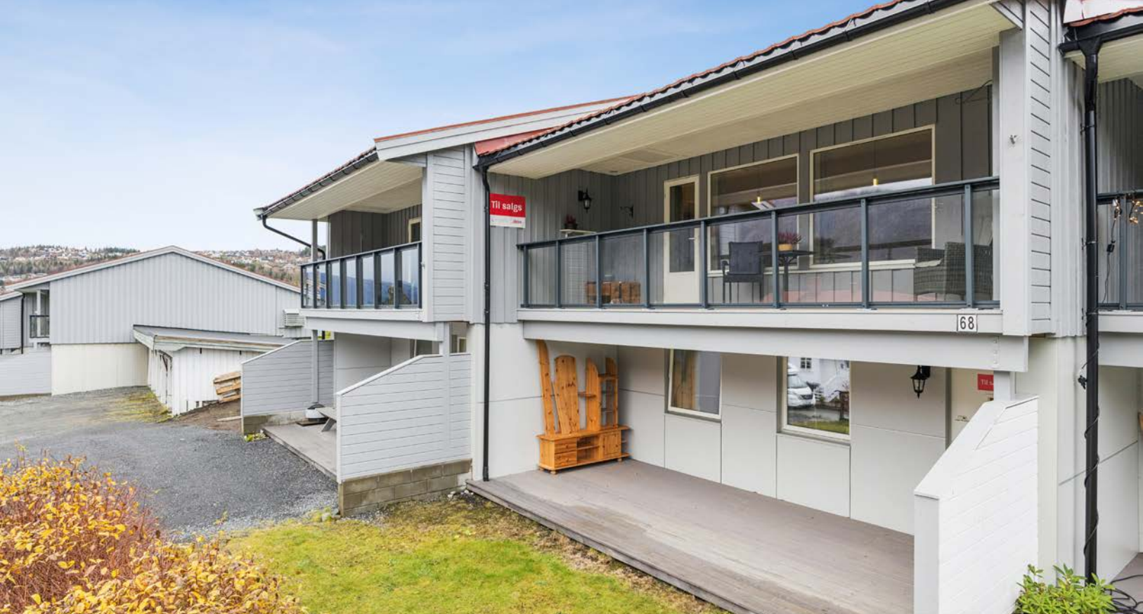
Terrassen på 13 m2 har glassrekkverk og er delvis fundamentert på betong og bjelkelag.
