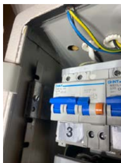
Manglende tetting av hull i elskap.
