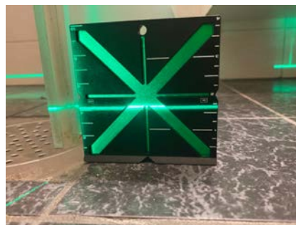
Måling av fall til sluk.
