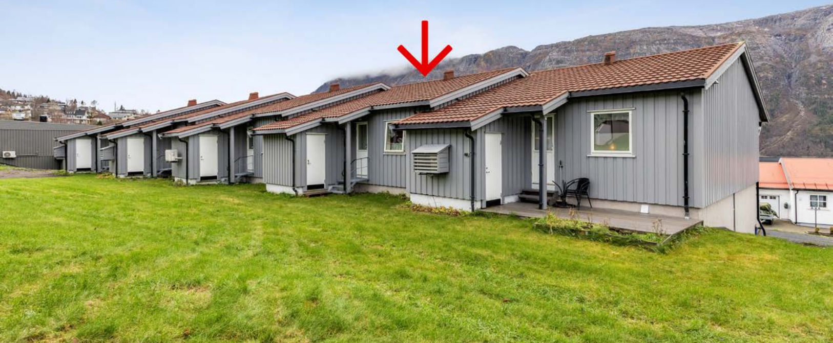
Rekkehus med god utsikt over Vefsnfjorden, sentralt beliggende nær skoler og barnehager.
