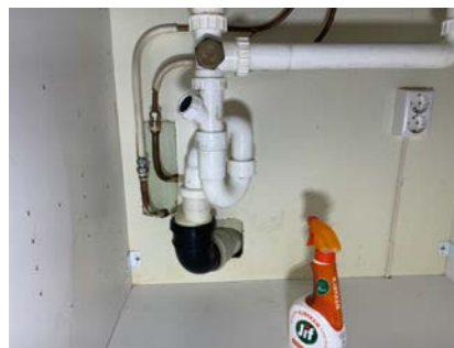
Kontroll av røropplegget.
