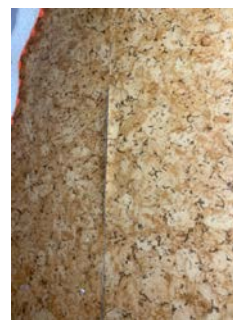
Skjøte på vinylbelegg i gangen, underetasjen.
