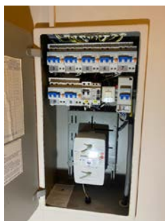
Manglende tetting av hull i elskap.
