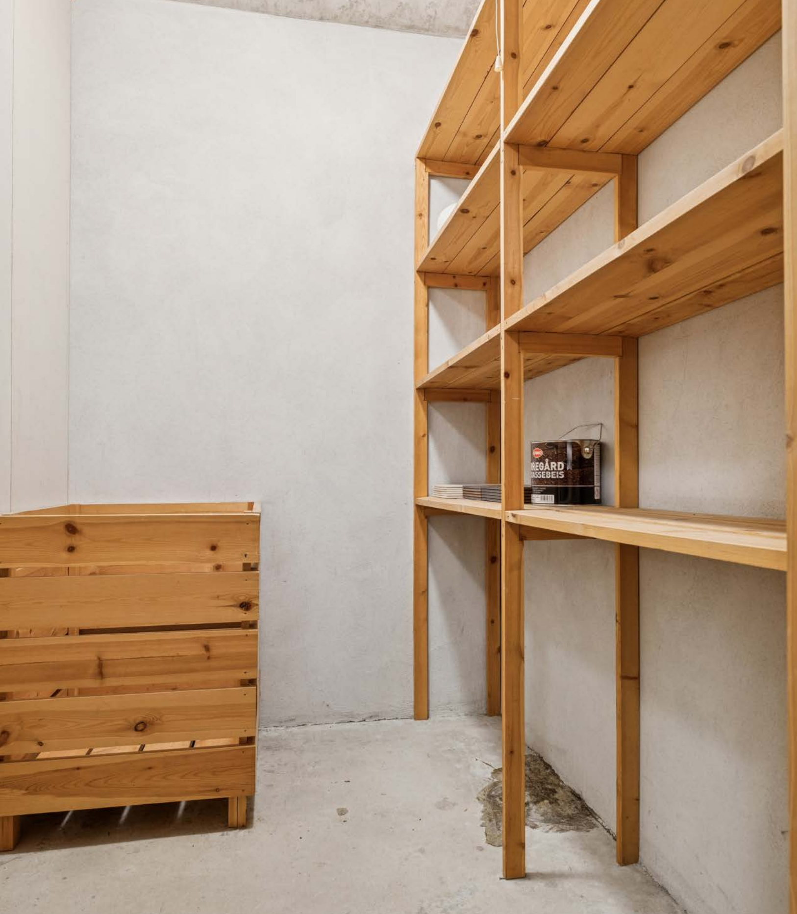
Innvendige vegger har malte plater, mens gulvet er av betong (kilde: tilstandsrapport).
