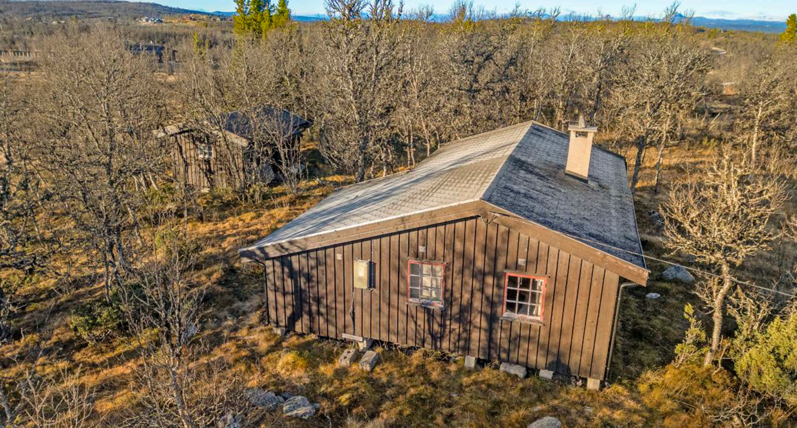
Uthus på eiendommen.
