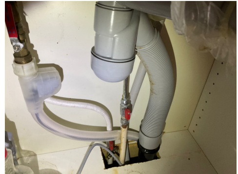
Rør på kjøkken
