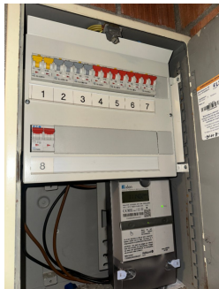
Sikringsskap med automatsikringer.
