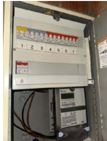
Sikringsskap med automatsikringer.
