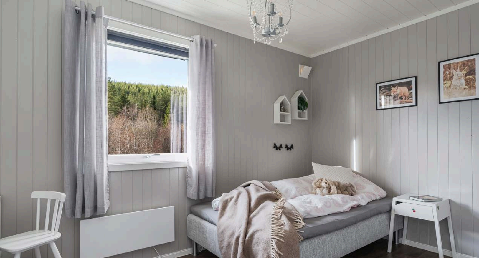
Soverommet har mørkt belegg på gulv og malte panelplater på veggene.
