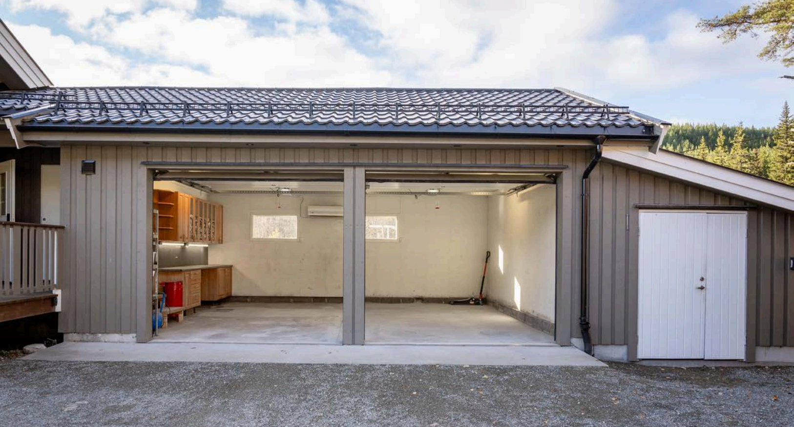
Inntilbygget dobbeltgarasje med to elektriske porter.
