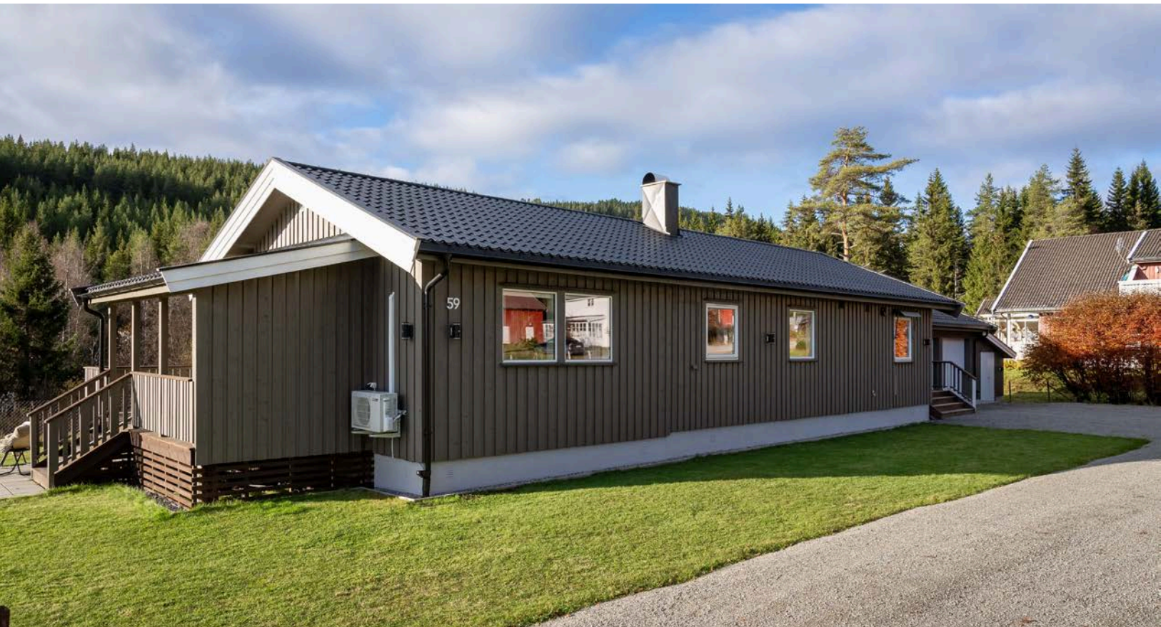
Boligen ble tilbygget og vesentlig oppgradert i ca. 2016-17 med bla. nytt yttertak, nye vinduer og dører m.m.
