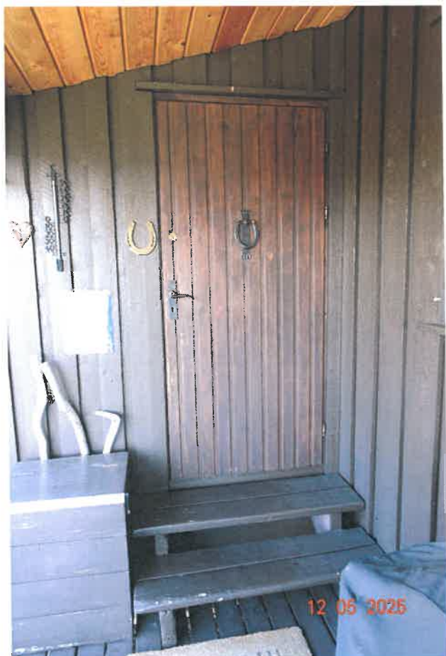
Panelt behandlet ytterdør.
