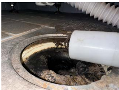
Plastsluk med klemring for membran
