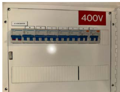
Sikringsskap med automatsikringer.
