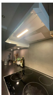
Ved test av avtrekksvifte som beskrevet i NS3600, fungerte viften som tiltenkt.
