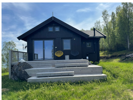
Det er ikke montert rekkverk på deler av altanen.
