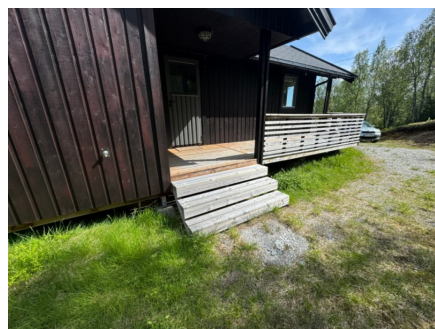
Det er ikke montert rekkverk på trappen.
