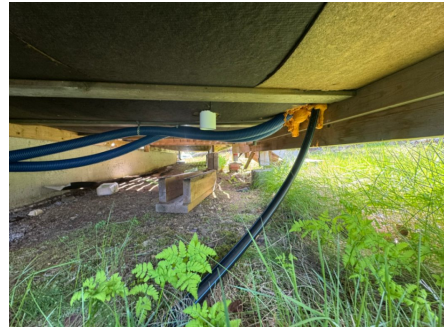
Fall mot grunnmuren.
