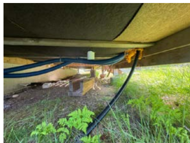
Fall mot grunnmuren.
