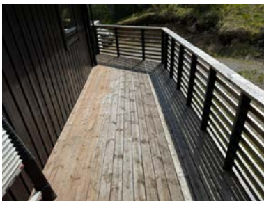
Det er ikke montert rekkverk på deler av altanen.
