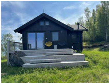
Det er ikke montert rekkverk på deler av altanen.
