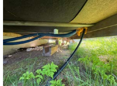
Fall mot grunnmuren.
