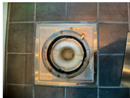
ETASJE > BAD - 2.1M2
