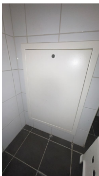
Luke til ventilasjonskanal. (ingen tilgang under befaring)
