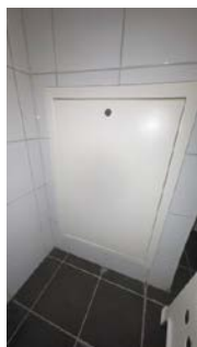
Luke til ventilasjonskanal. (ingen tilgang under befaring)
