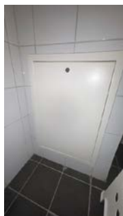
Luke til ventilasjonskanal. (ingen tilgang under befaring)
