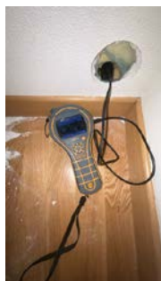
Sted for hulltaking er kjellerstue i U. etasje.
