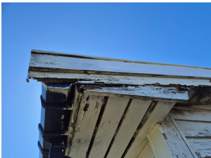
Råteskadet vindskier.
