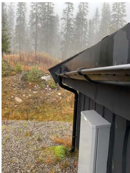
Manglende skjøt i takrenne.
