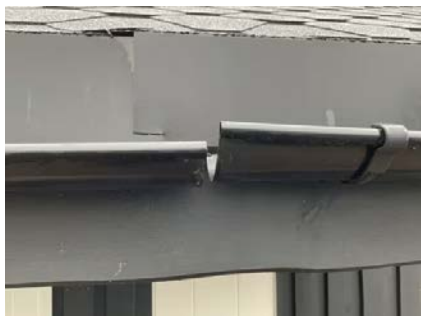
Manglende skjøt i takrenne.
