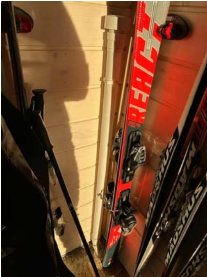
Lufting av kloakk.
