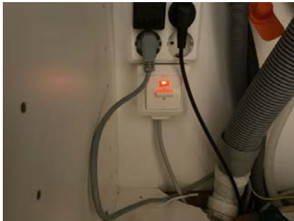
Fast tilkobling av bereder.
