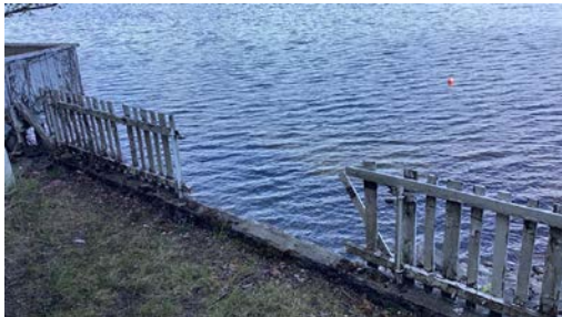
Mangler rekkverk.
