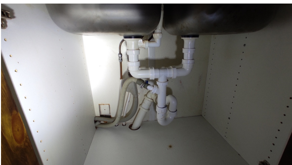
Kontroll av røropplegg.
