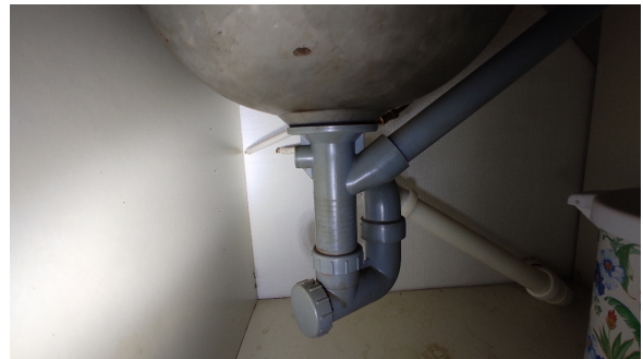
Kontroll av røropplegg.
