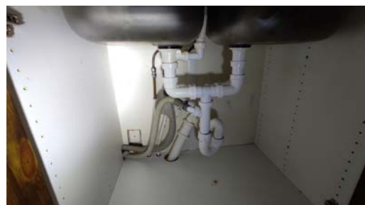
Kontroll av røropplegg.
