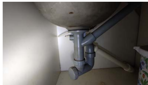
Kontroll av røropplegg.
