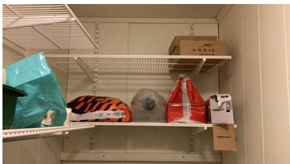
Vifte er plassert bak vegg på teknisk rom.
